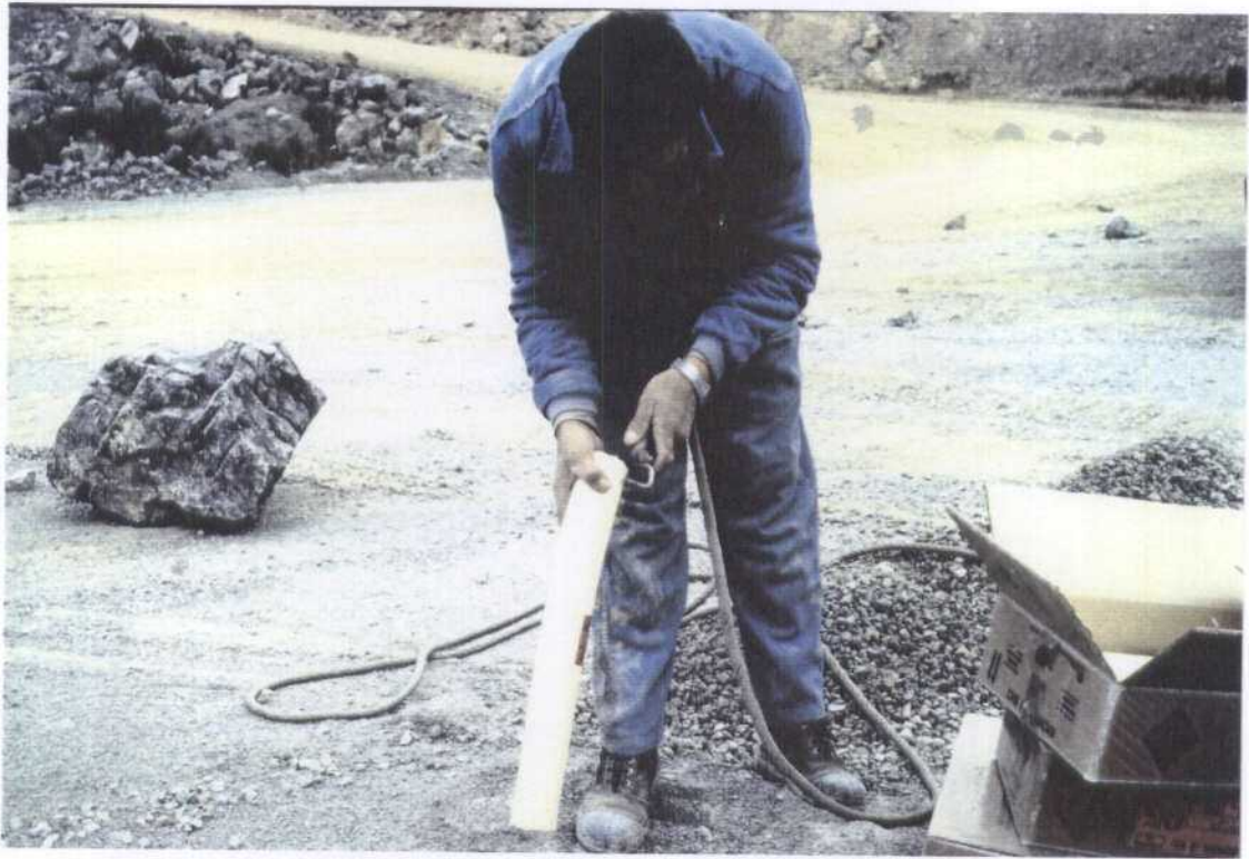
FOTO 1.- CARGA DE LA VOLADURA
