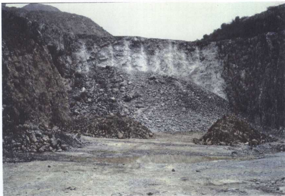
FOTO 4.- VISTA DEL FRENTE DESPUES DE LA VOLADURA Nº 2
